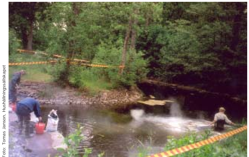
Spridning av släckt kal i Teakersälven för att skapa en kräftfri zon
