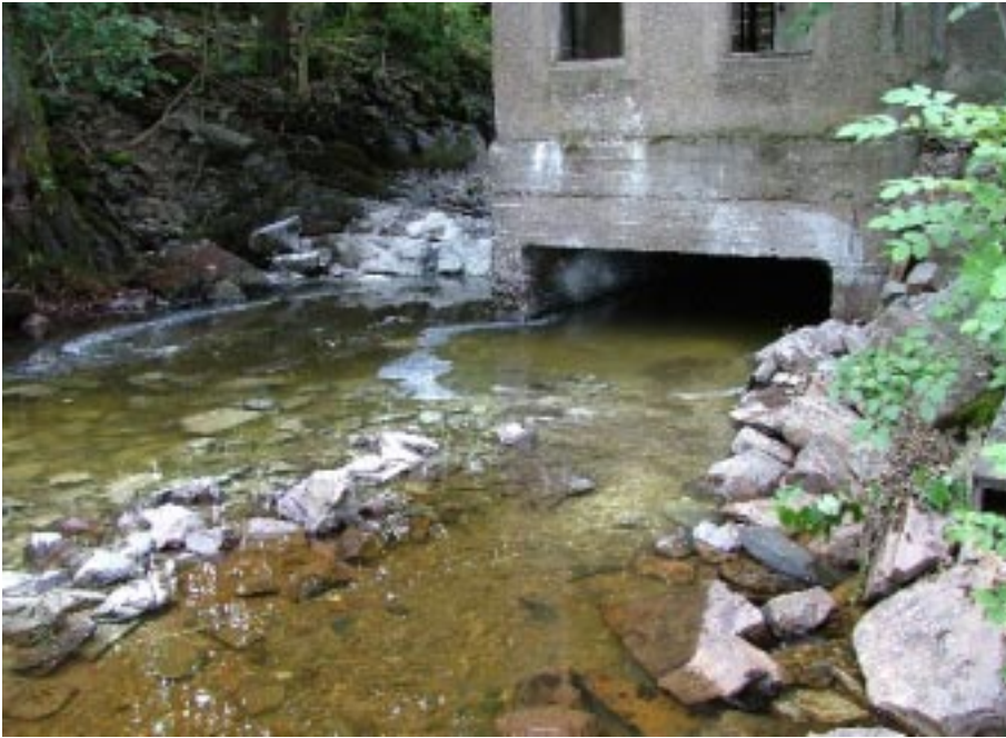
Nedströms den gamla kraftstationen vid Källsviken. Kalk har pudrats strandnära för att uppnå största möjliga effekt.
